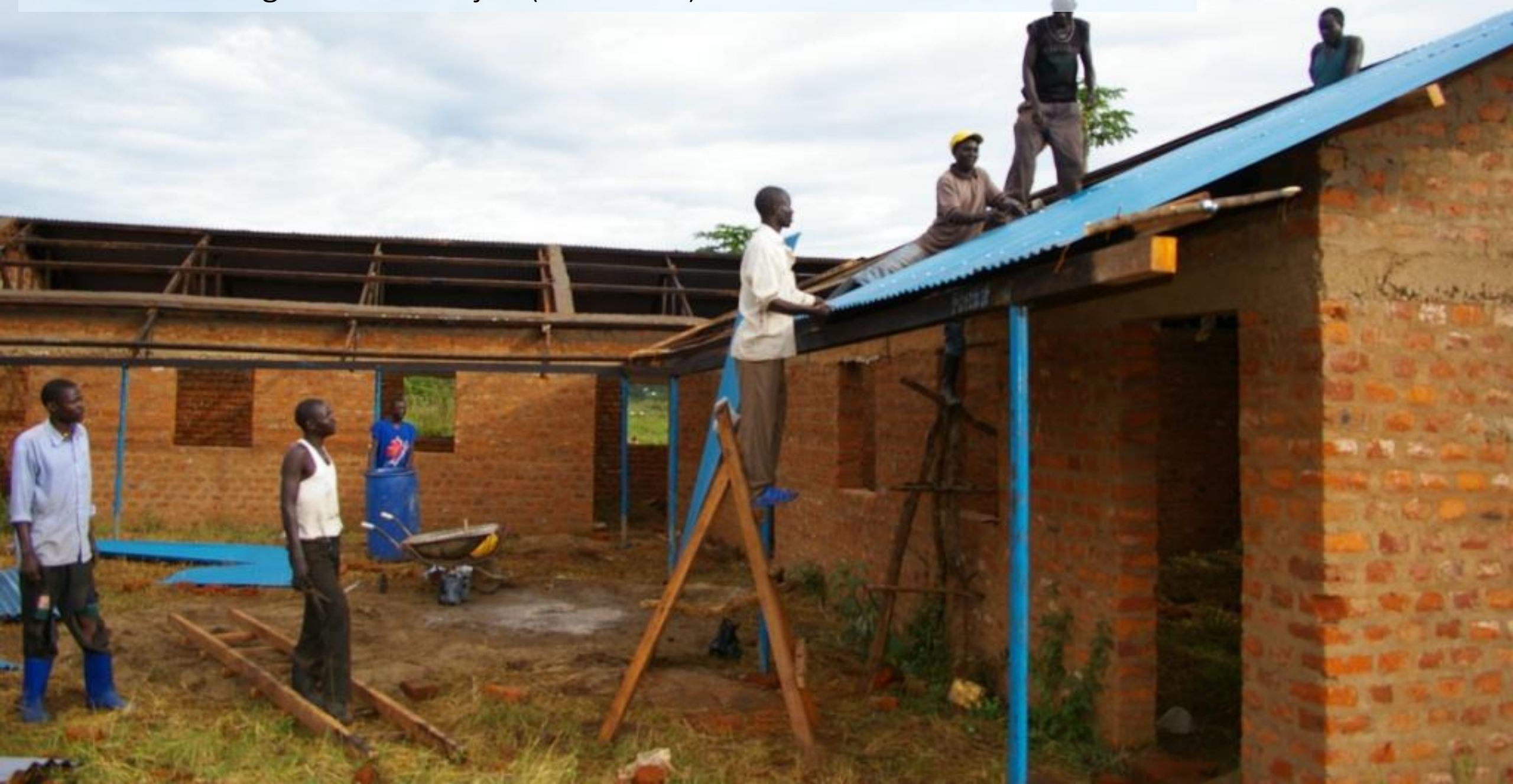
Bau erste Schulgebäude in Pajok (Südsudan) in fester Bauweise ab 2009
