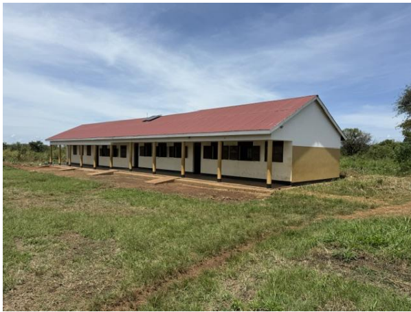
Schulgebäude am Standort Odwele, Pajok
