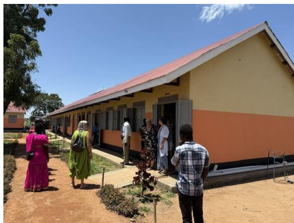
Neues Schulgebäude in Palabek
