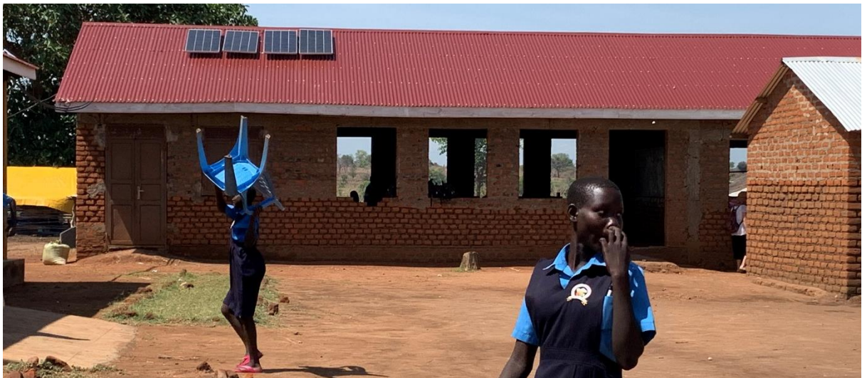
Neues Mehrzweckgebäude mit Solarpaneele
